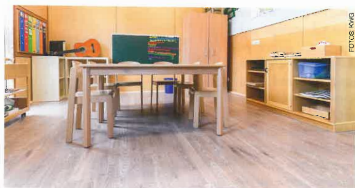
Beim Dekor fiel die Wahl auf das Design Japanische Eiche sägerau. Eine Kork-Composite Deckschicht wurde zusätzlich vor dem Druck aufgebracht.
